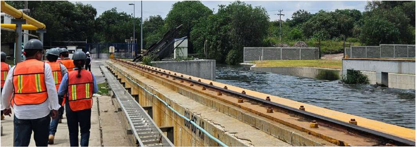
Fotografía 13. Planta de Tratamiento de Aguas Residuales de Atotonilco de Tula, Hidalgo
